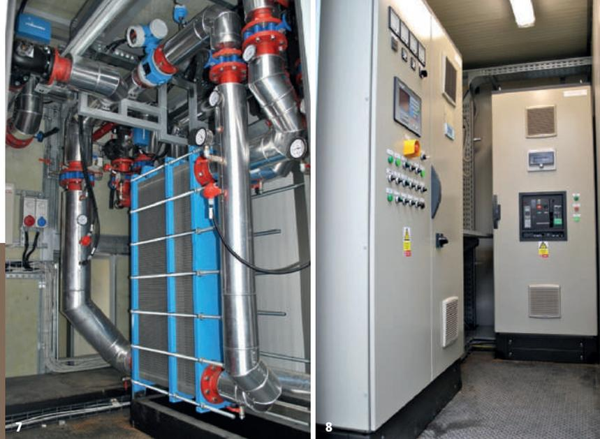
7. Dettaglio degli scambiatori e dei circuiti ad acqua calda
